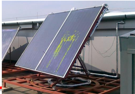
2 db forgó kollektor A_{absz}=4,8 \text{ m}^2
