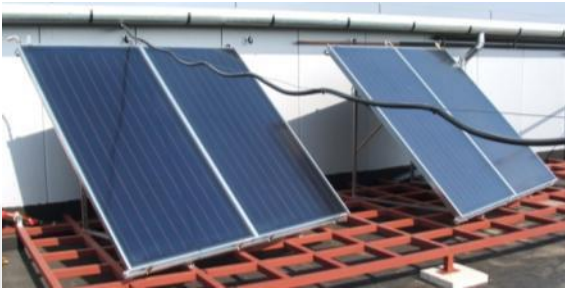
4 db álló kollektor A_{absz}=9,6 \text{ m}^2
