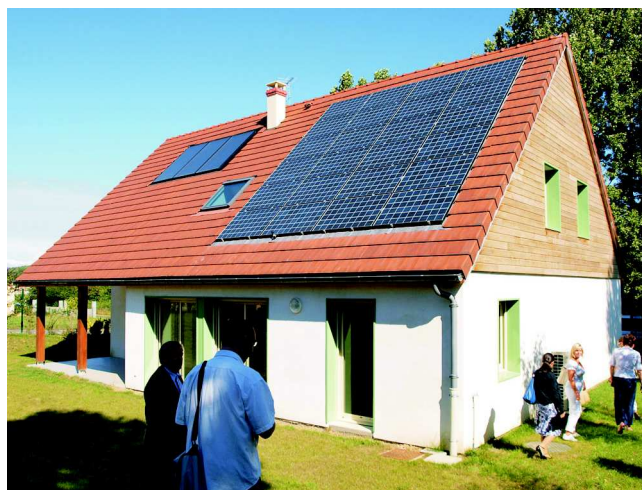
3. ábra. Egy kenderbeton épület minden jóval ellátva
