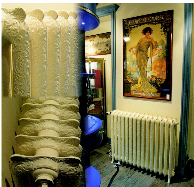
4. ábra. Öntöttvas radiátor és részletei a Pommery pezsgőpincészetben
